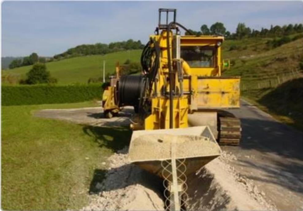
Figure 7 : Pose d'un câble avec une trancheuse
